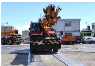
仮設道路の設置
