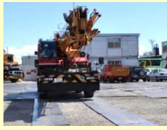
仮設道路の設置
